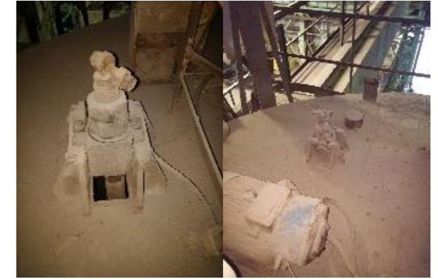
Şekil 7. C-Kanca Sabit Halat Ucu Bağlantısı.
