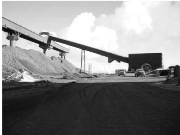
Şekil 15. Takonit konveyörü genel görünümü.
