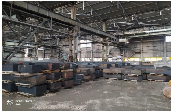
Şekil 8. Demontaj Edilen Karbon Tuğlalar
