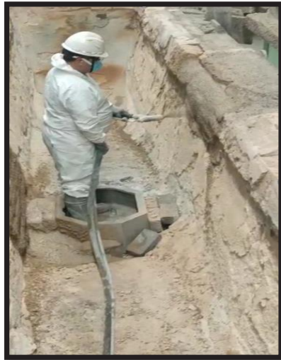
Şekil 1. Manuel slab tandiř püskürtme uygulaması.
