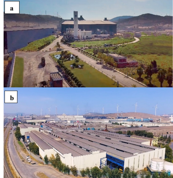
Şekil 1. (a) Çelikhane genel görünüm (b) Haddehane genel görünüm
