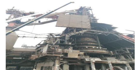
Şekil 5. Çelik Konstrüksiyon Demontajı
