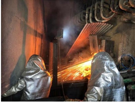
Şekil 11. Üst Salamander Oksijen Vurma İşlemi.
