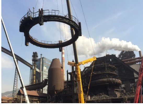
Şekil 6. Çelik Konstrüksiyon Demontajı
