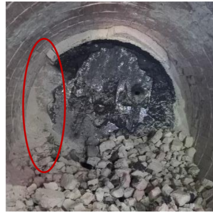
Şekil 6. Taban sökümüne başlangıç noktası
