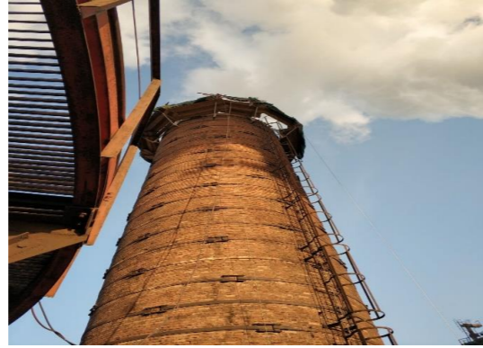
Şekil 10. Demontajı Yapılan Soba Tuğla Bacası
