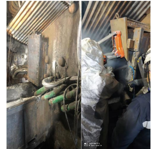
Şekil 7. Üst Salamander Kanalı Nozul ve Matkap Montajı.
