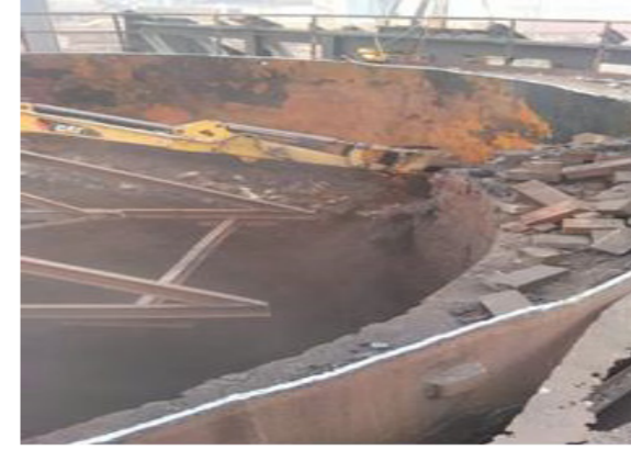
Şekil 12. Fırın İçinden İş Makinası ile Sökülen Tuğlalar
