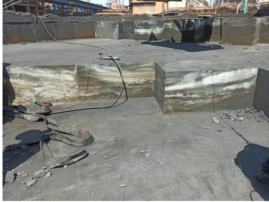
Şekil 7. Karbon Tuğla Demontajı
