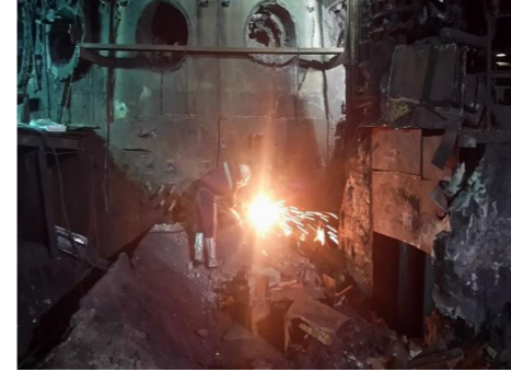
Şekil 1. Zırh ve Soğutucu Demontajı
