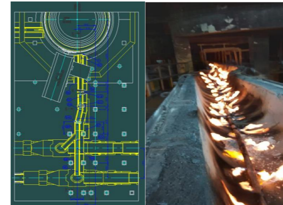
Şekil 6. Üst Salamander Kanalı ve Refrakter Kurutma.
