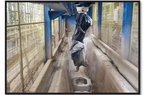
Şekil 6. Robotik slab tandiř püskürtme uygulaması
