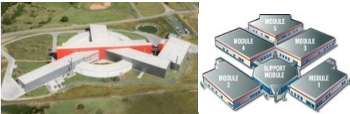
Şekil 39 : İş akışını düzenleyen ve ara stokları sıfırlayan bir döküm fabrikası (sol) ve modüler bir hassas döküm fabrikası (sağ) (29)
